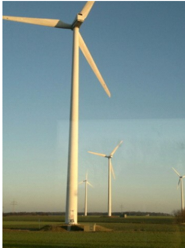
Fotografia 1. Turbina wiatrowa. Źródło: własny zbiór.
